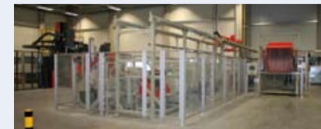
Pretrattamento: impianto di sgrassaggio e spruzzatura
