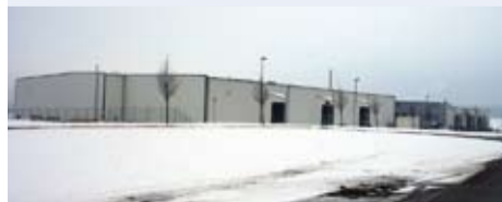
Il nuovo padiglione dello stabilimento di Obrigheim
