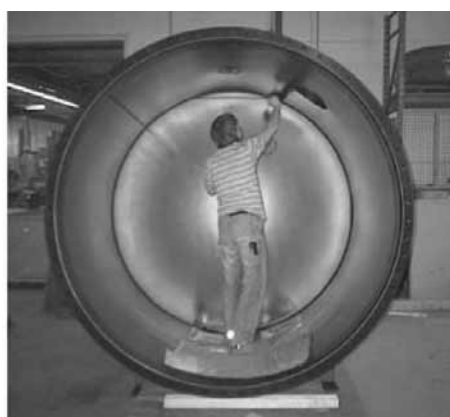
Protezione chimica contro il biodiesel.
